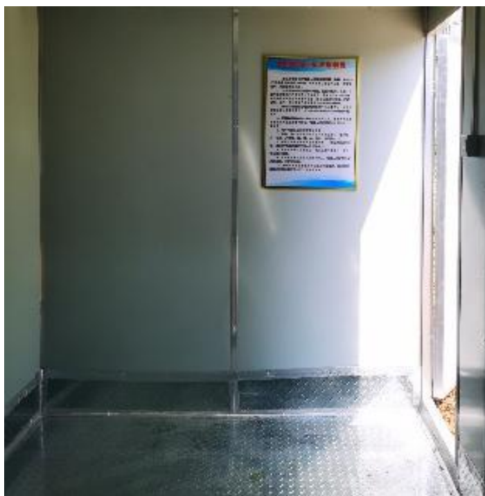
图 4.2-1 危废库地面防腐防渗
