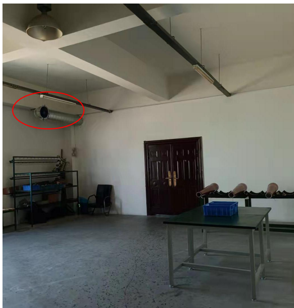
图 4.1-6 擦拭和粘胶区集气系统
