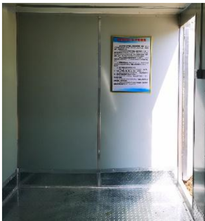
图 4.2-1 危废库地面防腐防渗
