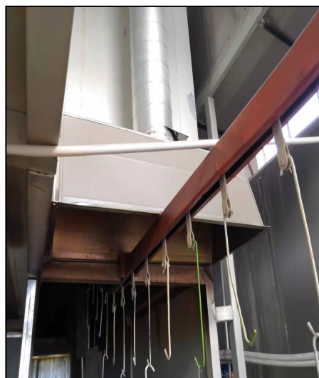
图 4.1-8 烘干、固化废气集气罩
