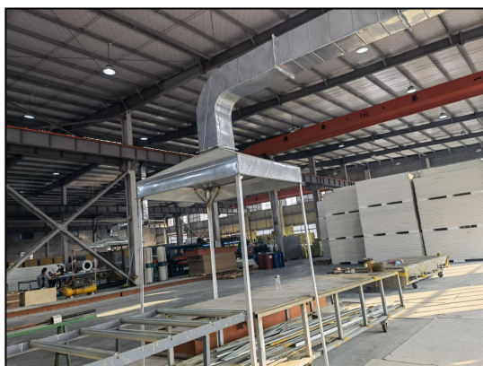
图 4.1-5 涂胶废气集气罩
