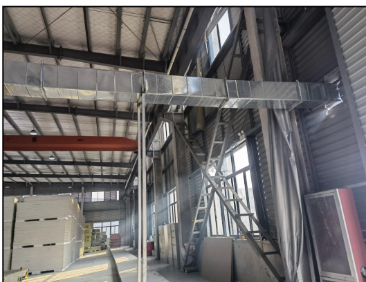
图 4.1-6 涂胶废气集气管
