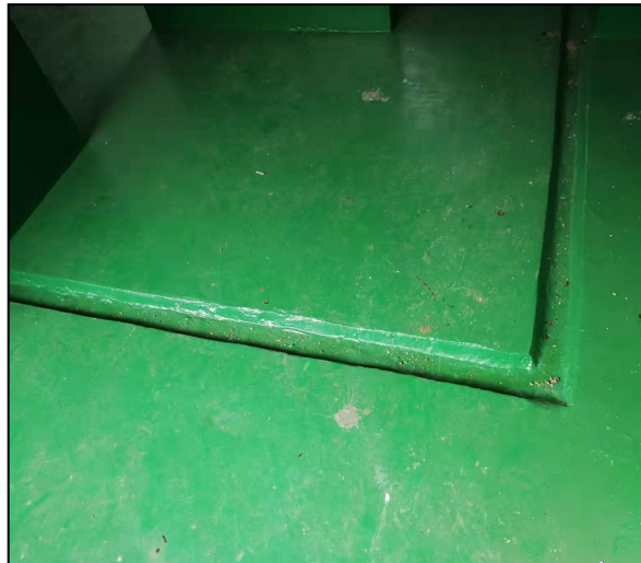
图 4.2-1 危废库地面防腐防渗
