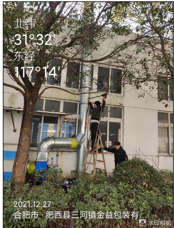
图 5-2 印刷废气处理设施出口监测照片
