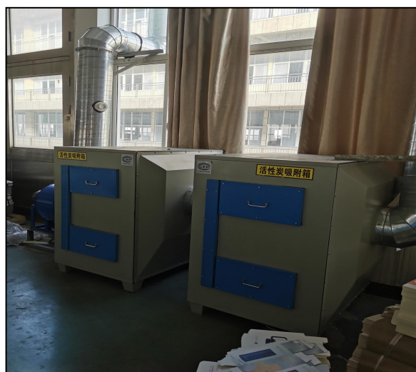
图 4.1-5 二级活性炭吸附箱（粘胶废气）
