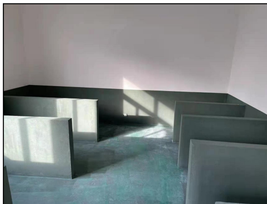
图 4.1-59 地面防腐防渗
