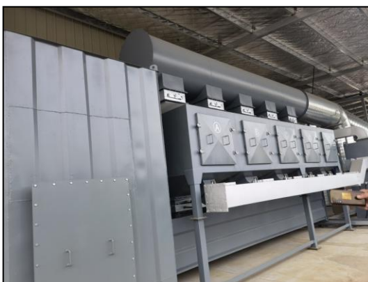
图 4.1-22 干式过滤+沸石吸附脱附热解装置
