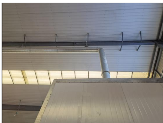
图 4.1-19 UV 打印室集气管
