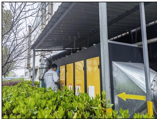
图 4.2-4 吸塑、点胶、挤板废气处理装置
