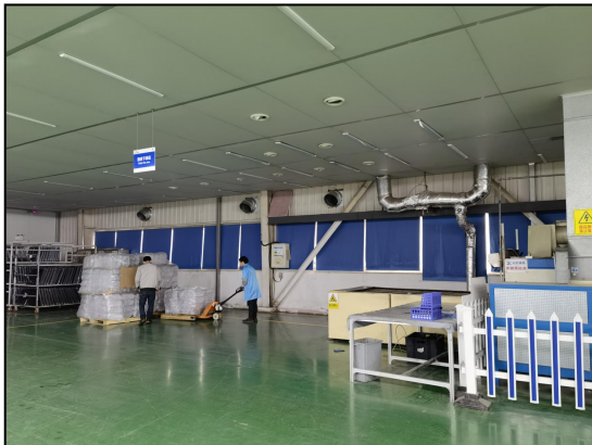
图 4.2-1 生产车间地面防腐防渗
