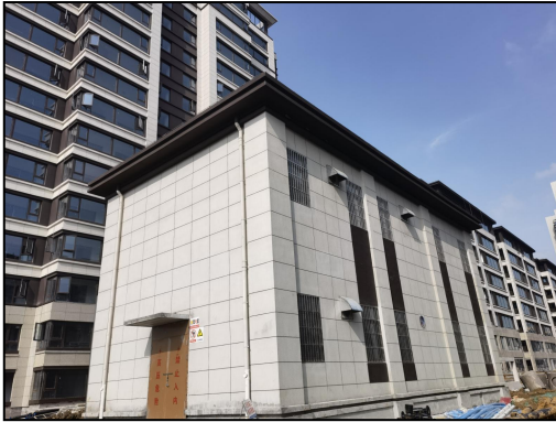
图 4.1-5 配电房专用设备房
