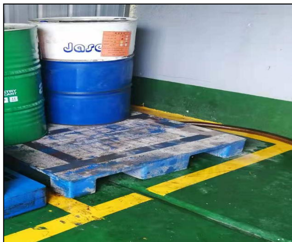
图 4.2-1 危废库地面防腐防渗
