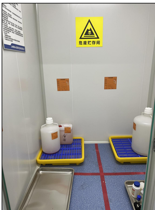
图 4.1-5 危废库（防泄漏托盘）
