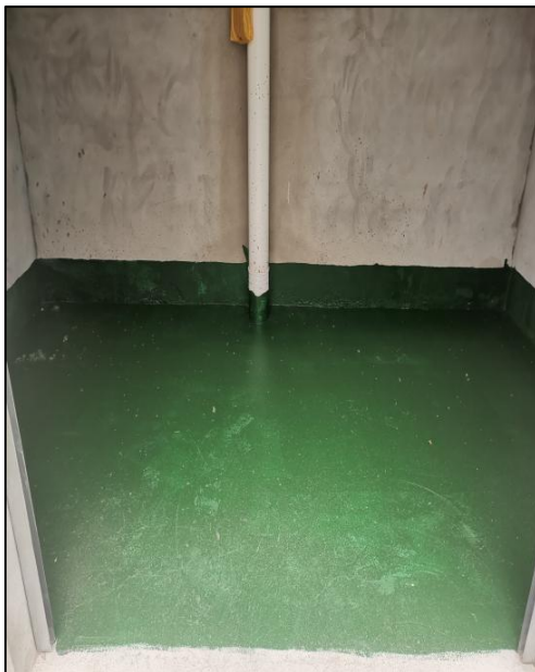
图 4.2-1 危废库内部防腐防渗
