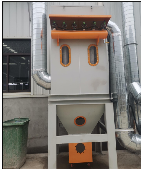
图 4.1-8 焊接烟尘净化器
