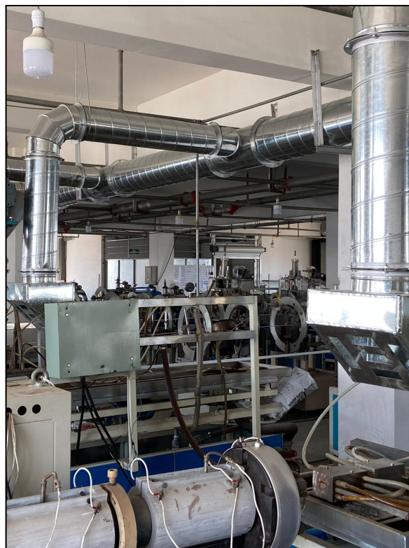
图 4.1-5 挤塑工序集气罩
