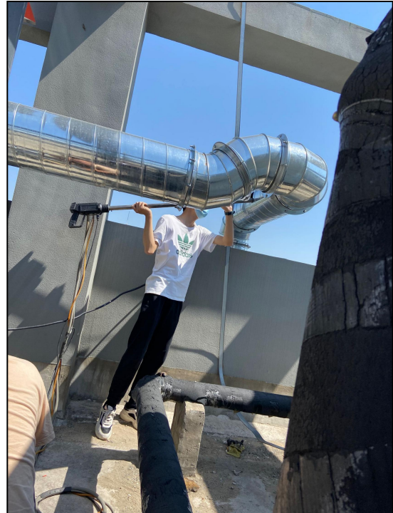
图 5-3 布袋除尘器进口监测照片
