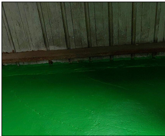
图 4.2-1 危废库地面防腐防渗
