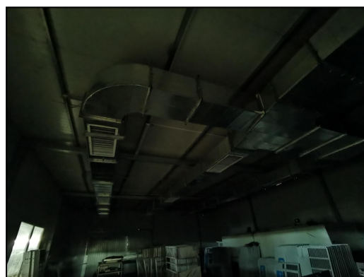
图 4.2-13 丝印房顶部集气口
