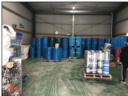
图 4.1-22 地面防腐防渗
