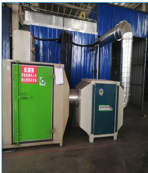
图 4.1-9 挤出工序（二级活性炭吸附装置）
