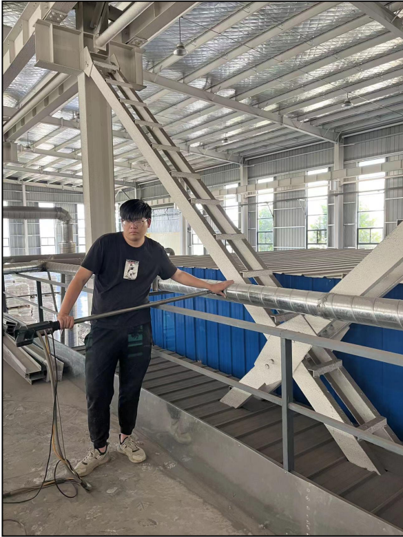
图 5-5 有组织废气监测照片 (DA001 排气筒进口)
