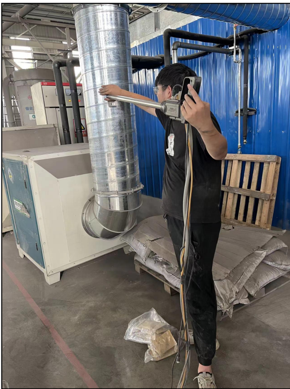
图 5-7 有组织废气监测照片 (DA002 排气筒进口)
