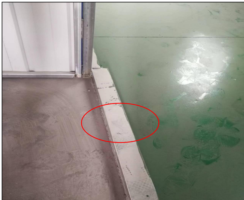
图 4.2-1 危废库地面防腐防渗
