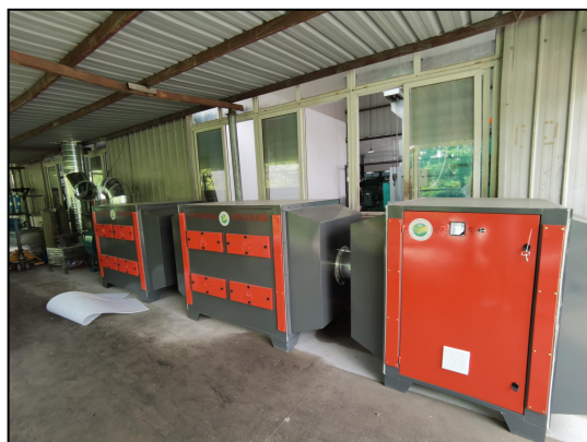
图 4.1-5 油烟净化器+二级活性炭吸附装置
