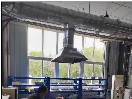
图 4.1-7 焊接工位集气罩（2）
