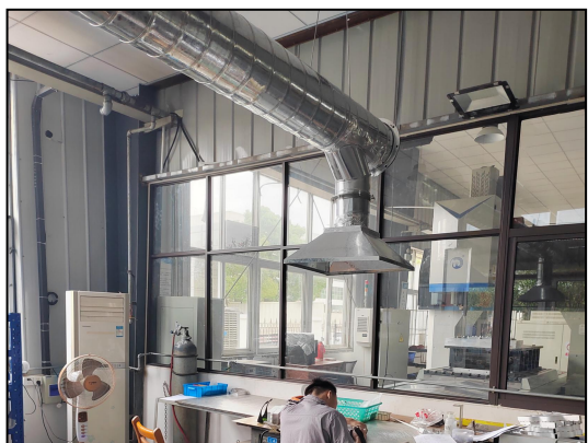
图 4.1-6 焊接工位集气罩（1）
