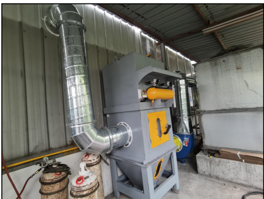
图 4.1-8 滤筒除尘器
