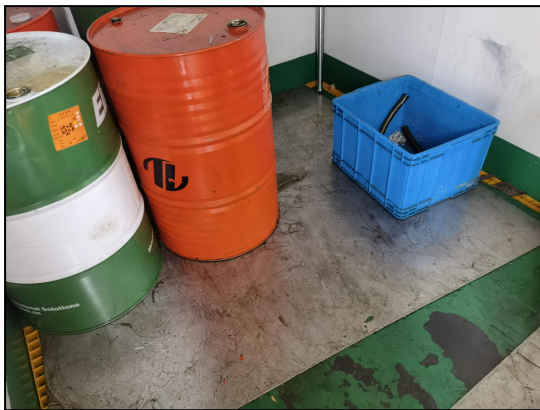
图 4.1-16 危废库地面防腐防渗
