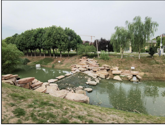
图 4-5 浮山路渠 2#拦水堰
