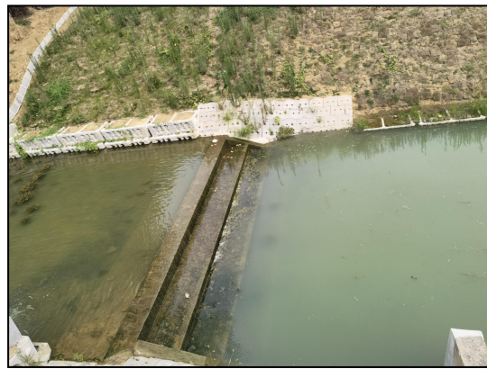
图 4-2 浮山路渠跌水堰
