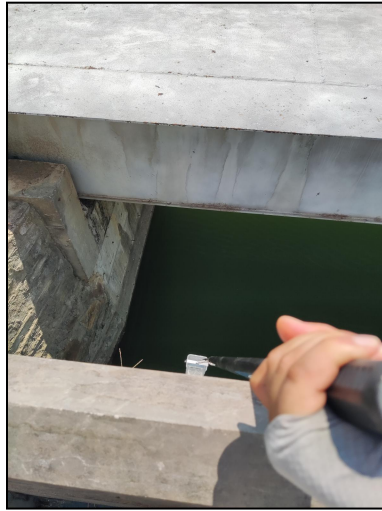
东支渠汇入柏堰湖入口
