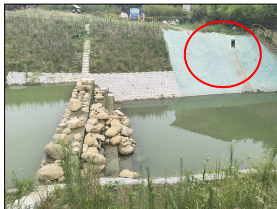
图 4-4 浮山路渠 1#拦水堰
