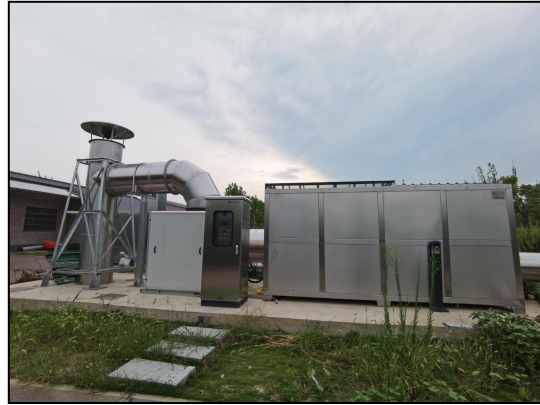
图 4-18 柏堰湖离子除臭装置
