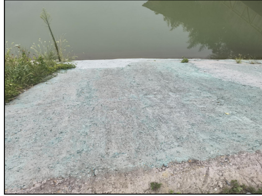
图 4-6 浮山路渠驳岸挡墙
