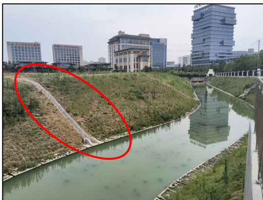
图 4-3 浮山路渠排水沟
