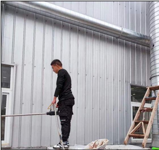
图 5-7 有组织废气监测照片 (DA002 排气筒进口)
