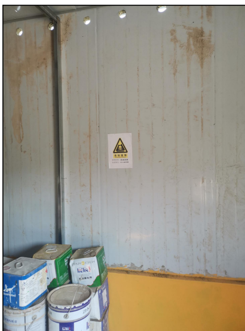
图 4.2-1 危废库地面防腐防渗
