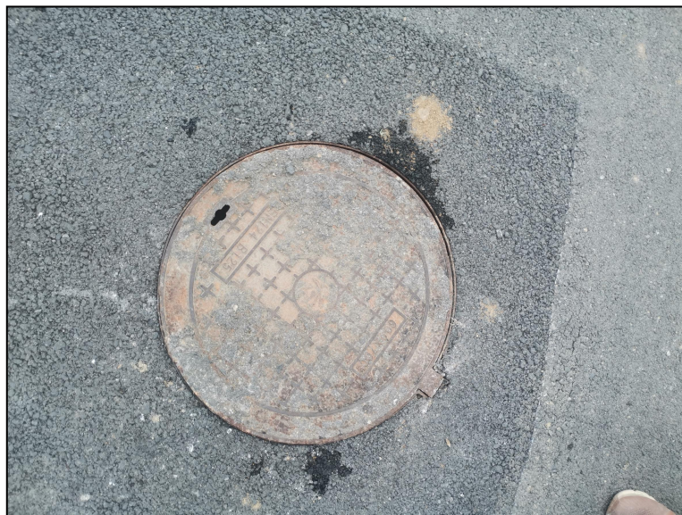
图 4.1-1 厂区东侧污水总排口照片
