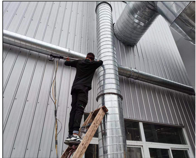
图 5-8 有组织废气监测照片 (DA002 排气筒出口)
