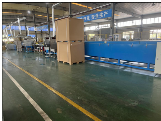
图 4.2-1 1#厂房 1 层地面防腐防渗
