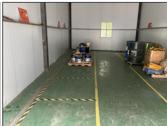
图 4.2-2 危废库地面防腐防渗
