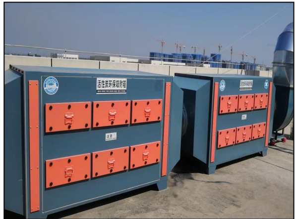
图 4.1-7 过滤棉+二级活性炭吸附装置
