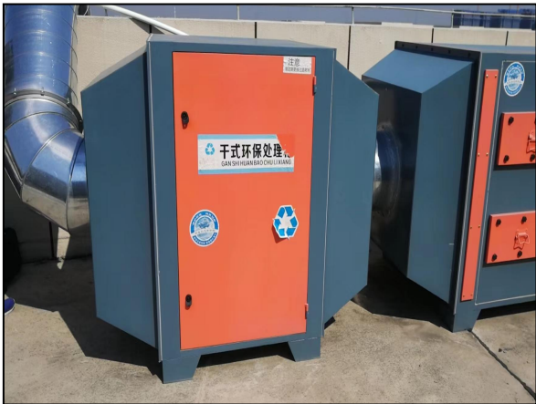
图 4.1-7 过滤棉+二级活性炭吸附装置
