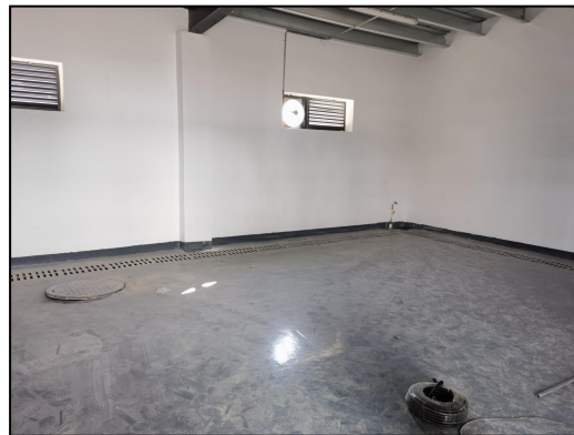
图4.1-10 地面防腐防渗
