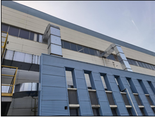
图 4.1-7 集气总管
