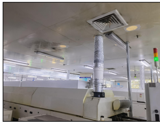
图 4.1-4 波峰焊集气管
