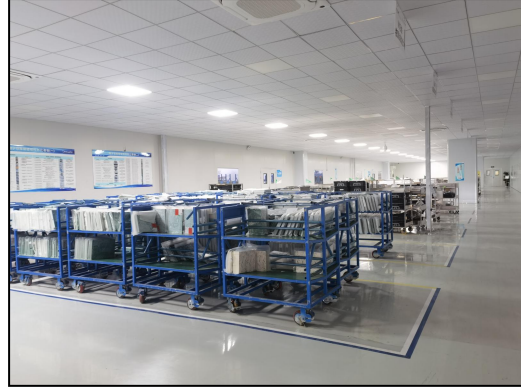
图 4.2-2 生产车间地面防腐防渗
