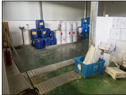
图 4.2-4 危险品库地面防腐防渗
