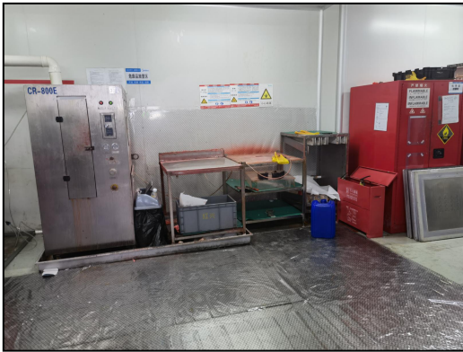
图 4.2-3 钢网清洗区地面防腐防渗
