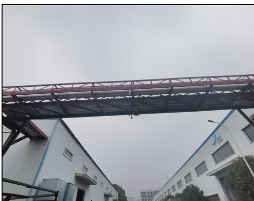
图 4.1-18 送料系统管道
