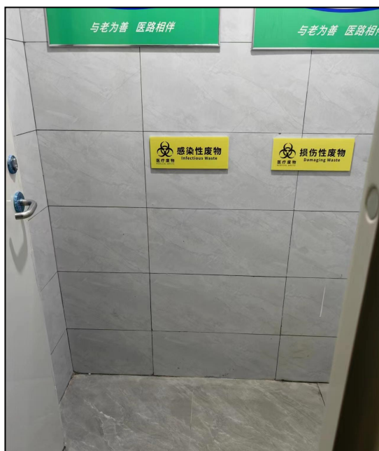
图 4.1-10 医疗废物暂存间内部（3层）
