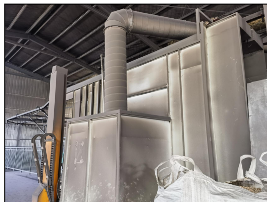
图 4.1-4 喷粉粉尘集气管道
