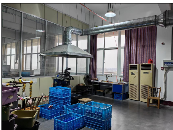
图 4.1-6 印花、网版擦拭工序集气罩
