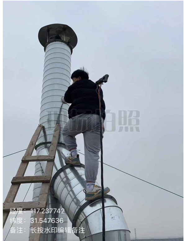
图 5-6 有组织废气监测照片 (DA001 排气筒出口)
