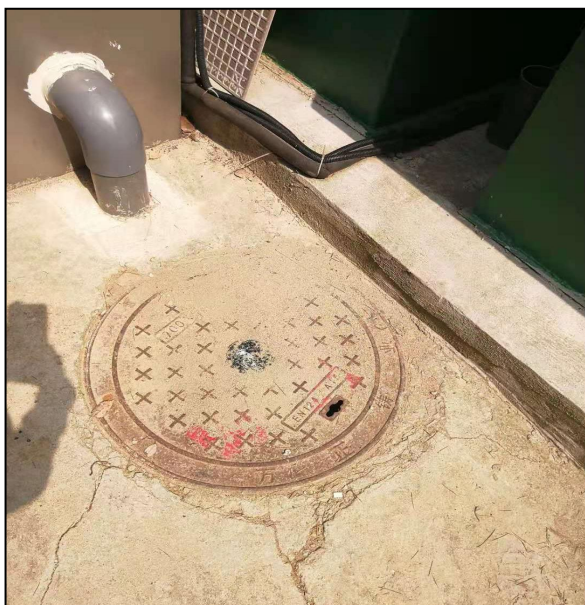
4.1-2 污水处理站排放口
