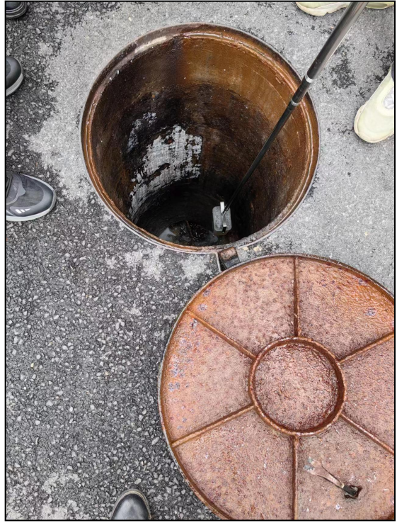
图 5-2 废水监测照片（污水总排口）
