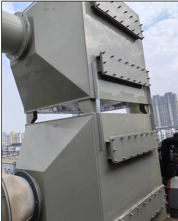
图 4.1-8 二级活性炭吸附装置 (TA005) 及 DA001 排气筒
