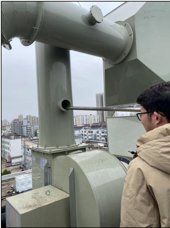
图 5-6 有组织废气监测照片 (DA001 排气筒出口)
