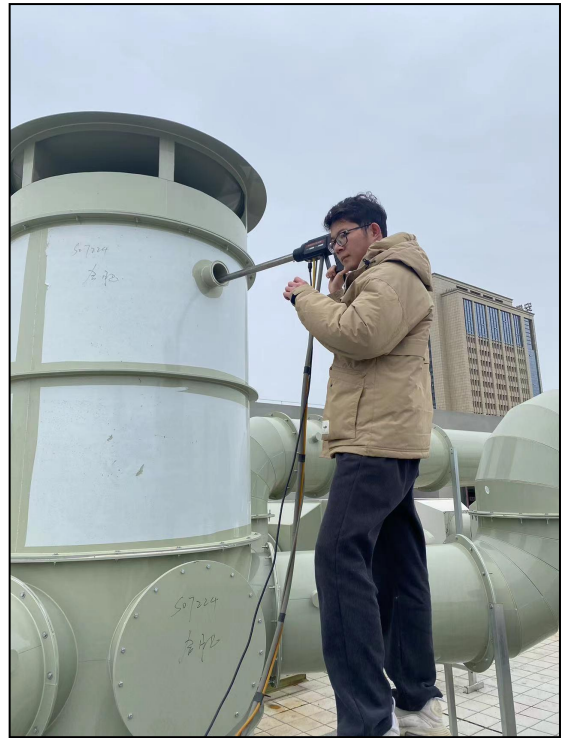
图 5-7 有组织废气监测照片 (DA002 排气筒出口)
