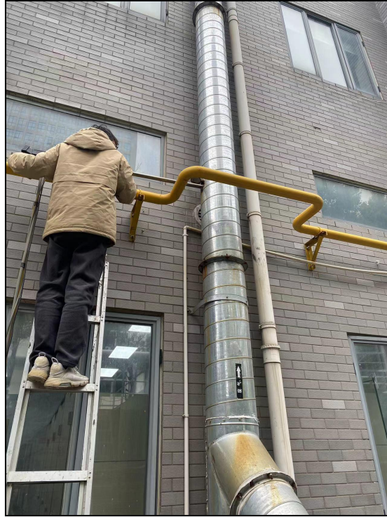
图 5-8 有组织废气监测照片 (DA003 排气筒出口)
