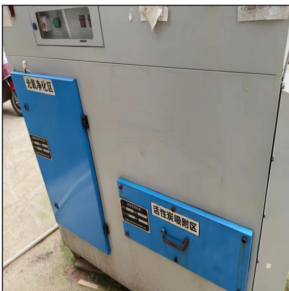
图 4.1-15 UV 光解+活性炭吸附装置及 DA003 排气筒
