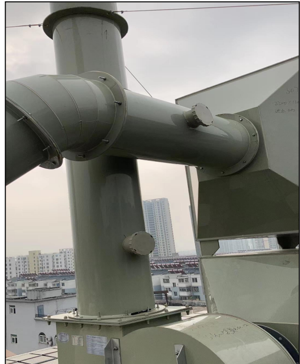
图 4.1-8 二级活性炭吸附装置 (TA005) 及 DA001 排气筒
