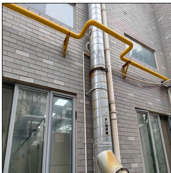
图 4.1-15 UV 光解+活性炭吸附装置及 DA003 排气筒
