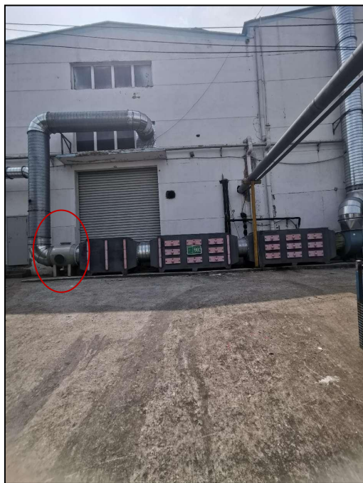
图 4.1-15 干燥器+过滤棉+二级活性炭吸附装置
