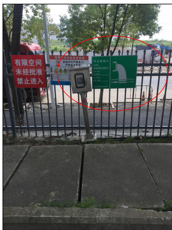
图 4.1-43 污水总排口规范化
