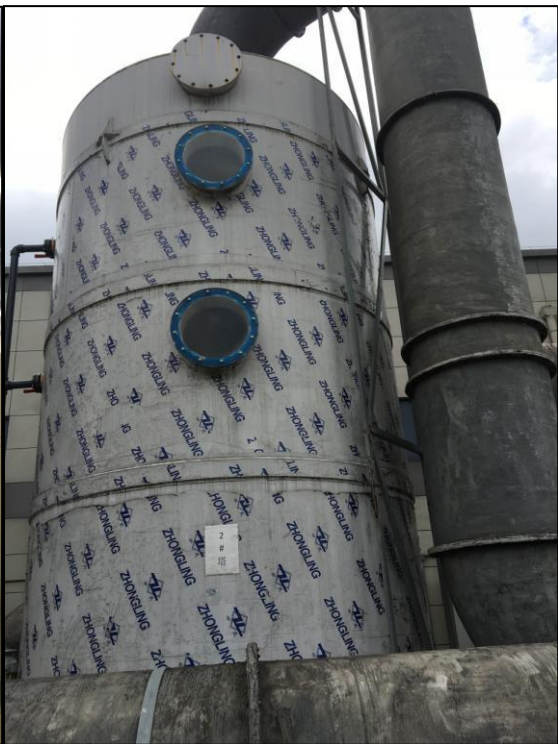
图4.1-14 酸雾喷淋塔
