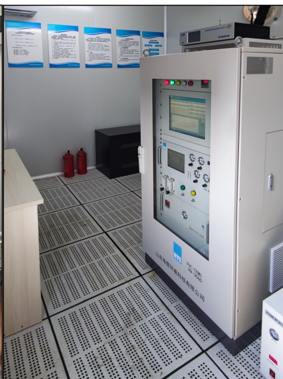
图 4.1-42 VOCs 在线监测装置
