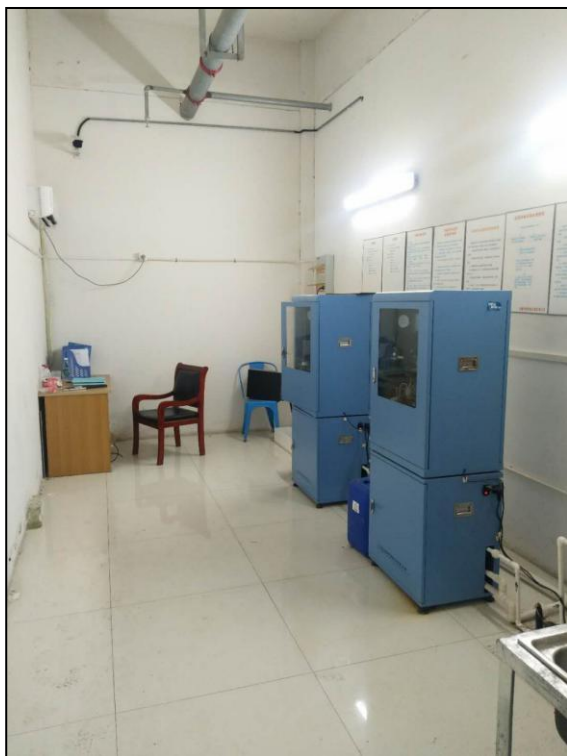
图 4.1-39 COD、NH 3 -N 在线监测装置
