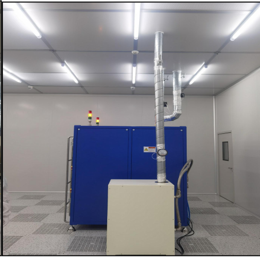
4.1-8 烘烤机废气收集
