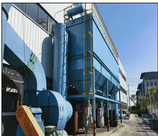
图 4.1-7 脉冲布袋除尘器
