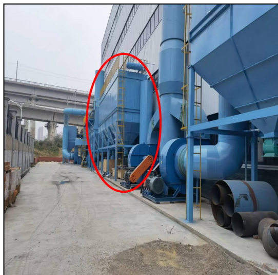
图 4.1-6 脉冲布袋除尘器
