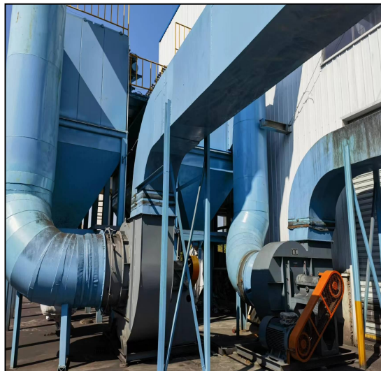
图 4.1-15 脉冲布袋除尘器
