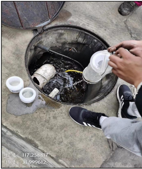
图 1 项目区总排口
