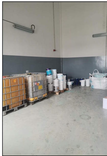
4.1-24 危废库内部防腐防渗
