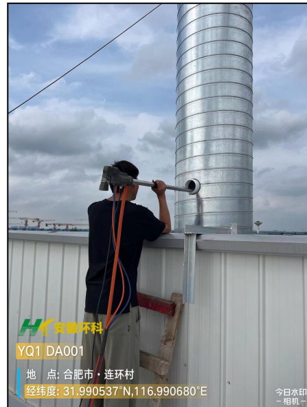
图 3-4 有组织废气监测照片 (DA001 排气筒出口)
