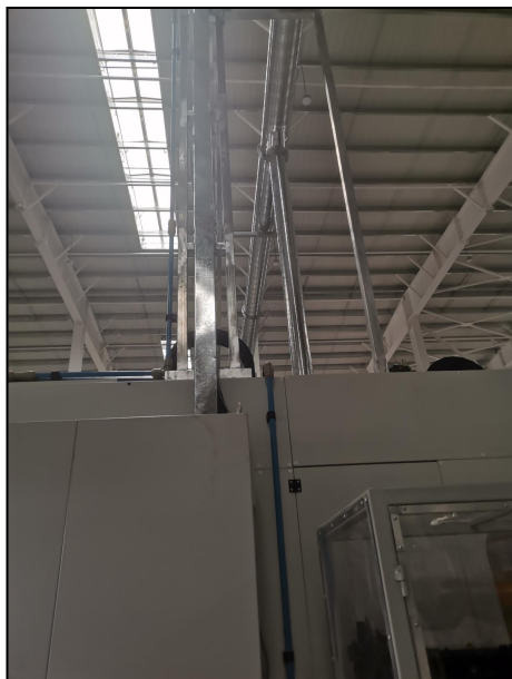
图 4.1-8 超声波焊接管道
