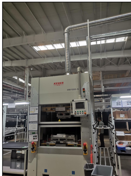
图 4.1-9 热板焊接管道
