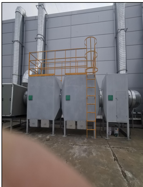
图 4.1-15 干式过滤器+二级活性炭吸附装置 (TA002) 图 4.1-16 DA002 排气筒
