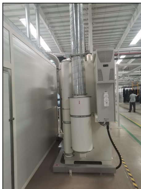
图 4.1-7 激光弱化设备自带过滤净化装置
