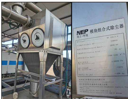
图 4.1-9 滤筒除尘器（设备自带）
