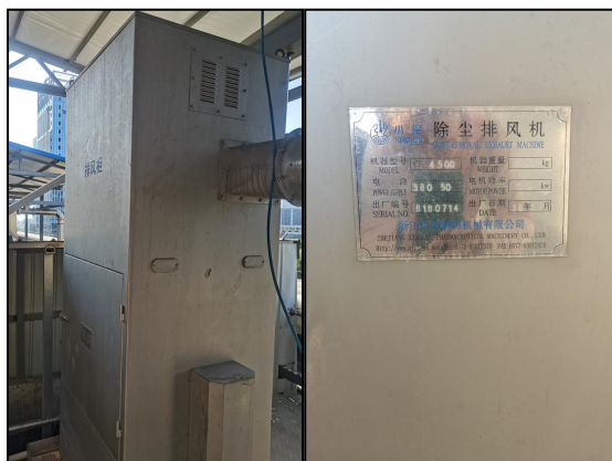
图 4.1-8 除尘排风机（设备自带）
