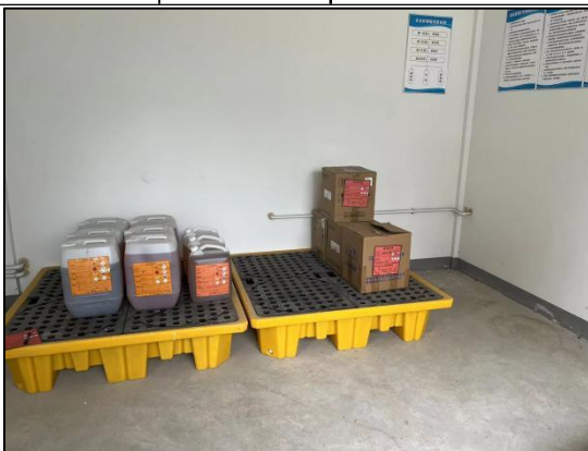
图 4.1-15 危废库防泄漏托盘
