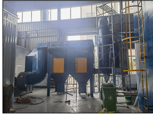
图 4.1-16 大旋风+滤芯除尘器 (TA004)
