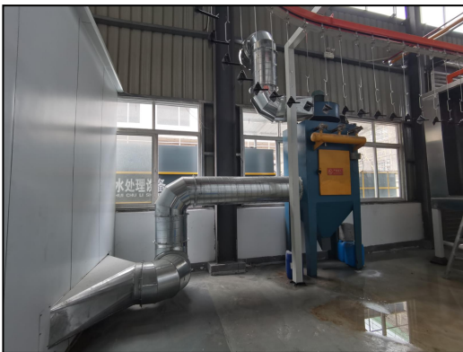
图 4.1-12 滤筒除尘器 (TA003)
