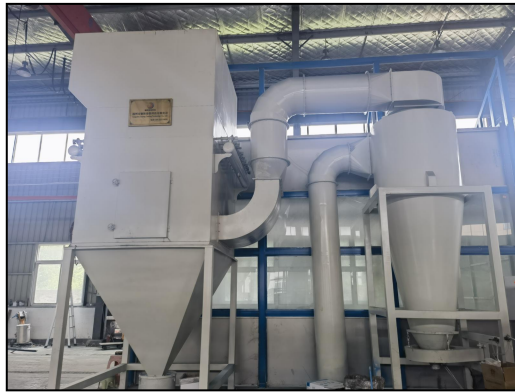
图 4.1-22 大旋风+滤筒除尘装置 (TA007)
