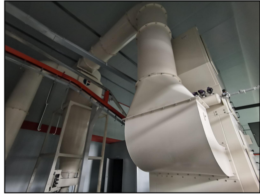
图 4.1-21 大旋风+滤芯除尘器 (TA006)
