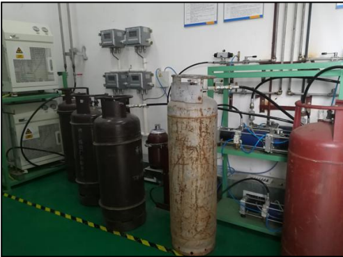
图 4.2-15 配气房地面防腐防渗
