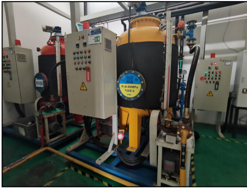
图 4.2-5 配料间地面防腐防渗
