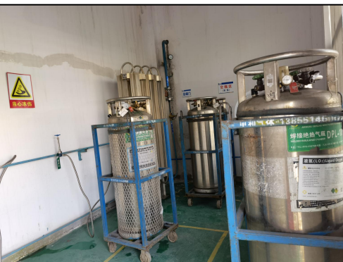
图 4.2-11 氧气房地面防腐防渗
