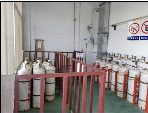
图 4.2-7 乙炔房防倾倒装置
