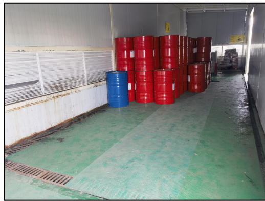
图4.1-30 地面防腐防渗
