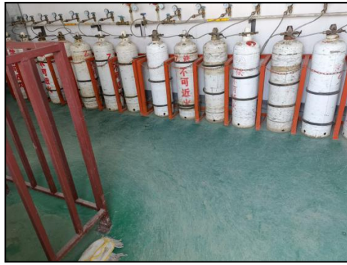
图 4.2-6 乙炔房地面防腐防渗
