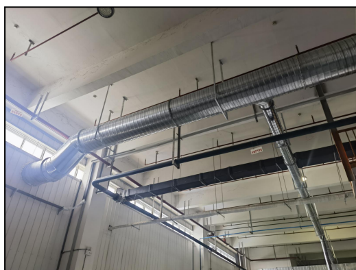
图 4.1-6 集气总管
