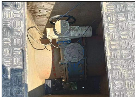
图 4.2-23 雨水排口截流阀
