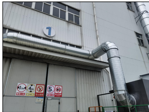
图 4.1-17 集气总管
