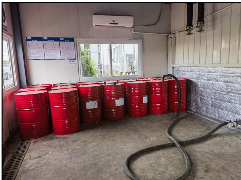
图 4.2-1 黑白料房地面防腐防渗
