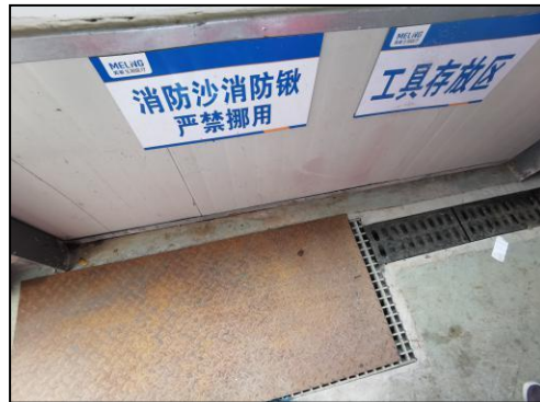
图 4.2-2 导流沟收集槽
