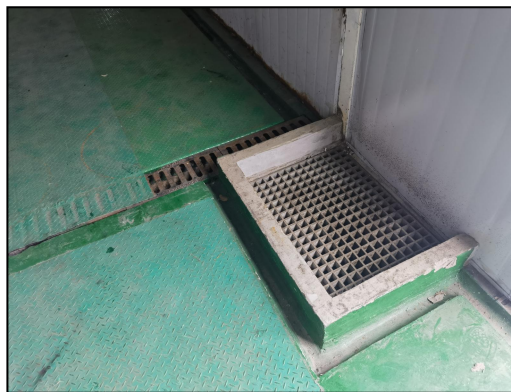
图 4.1-31 导流沟收集槽
