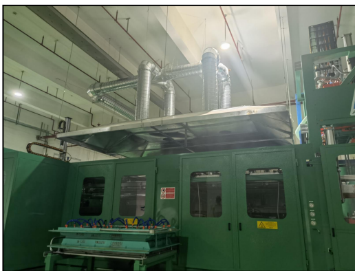
图 4.1-21 吸塑工位集气罩
