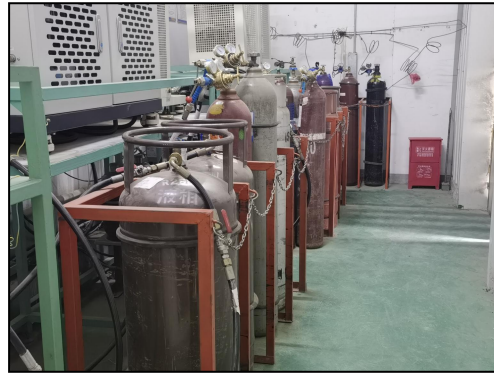
图 4.2-14 防倾倒装置和地面防腐防渗
