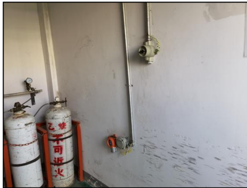
图 4.2-8 乙炔房可燃气体报警器
