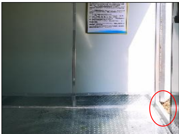
图 4.2-1 危废库（地面防腐防渗及门口围挡）
