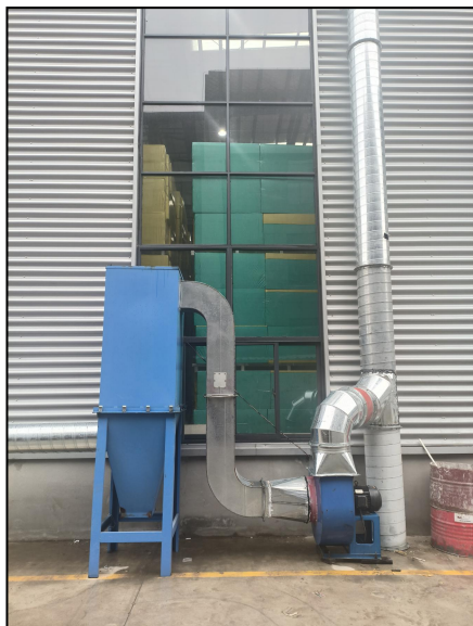
图 4.1-5 布袋除尘器 (TA002) +DA002 排气筒
