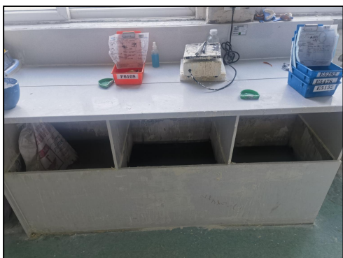
图 4.2-1 沉淀池防腐防渗
