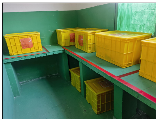
图 4.1-15 地面防腐防渗
