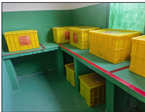
图 4.2-4 危废库地面防腐防渗
