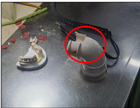
图 4.1-5 打磨工位侧边集气口
