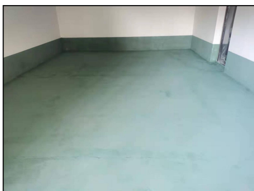
图 4.2-1 化学品库地面防腐防渗
