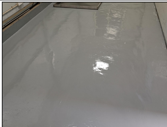
图 4.1-15 地面防腐防渗
