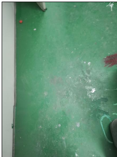
图 4.2-2 调漆房防腐防渗
