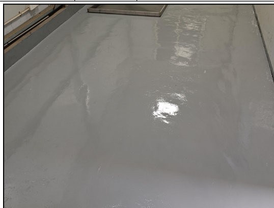
图 4.1-15 地面防腐防渗
