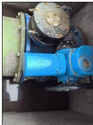
图 4.2-4 切断阀
