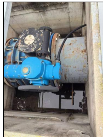
图 4.2-2 切断阀
