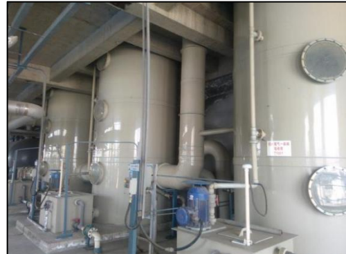
图 4.1-13 切片废气处理装置（三级碱液喷淋塔）
