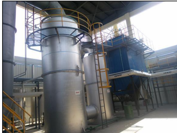
图 4.1-9 焚烧炉废气处理措施
