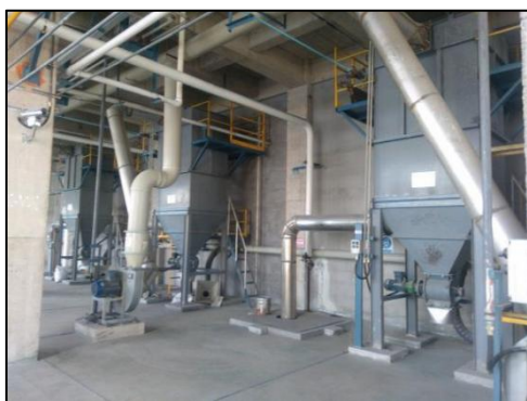
图 4.1-12 切片废气处理装置（布袋除尘器）
