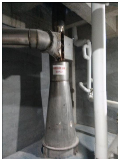
图 4.1-11 切片废气处理装置（旋风除尘器）
