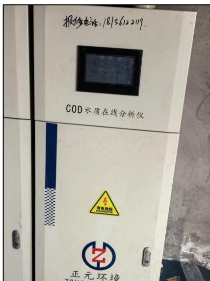
图 4.1-2 COD 在线监测装置照片
