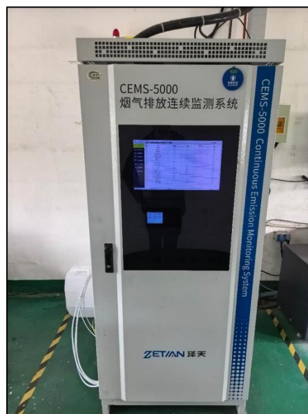
图 4.2-19 废气 CEMS 在线监测设备
