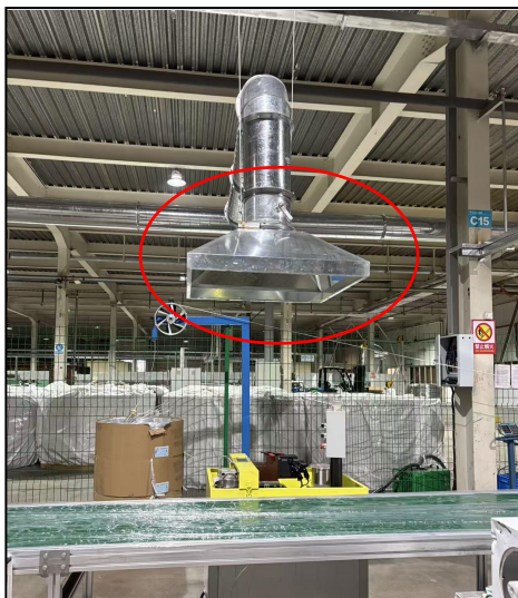
图 4.1-3 缩口平口工序集气罩
