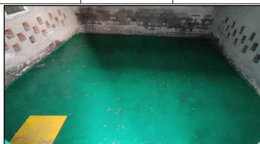
图 4.1-10 危废库地面防腐防渗
