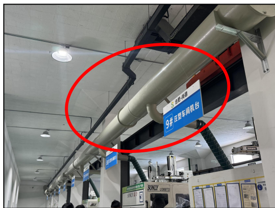
图 4.1-4 集气总管
