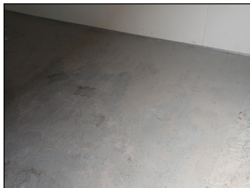
图 4.1-14 地面防腐防渗
