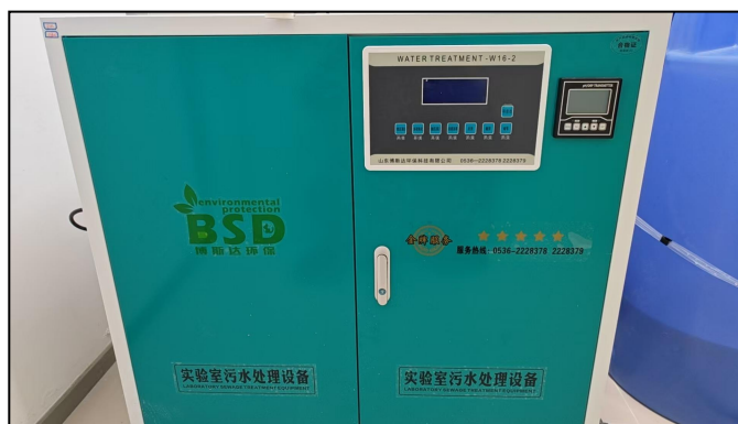
图 4.1-3 实验室一体化污水处理设备
