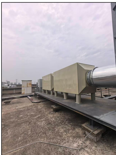
图 4.1-8 干式过滤器+二级及活性炭吸附装置 (TA004) 图 4.1-9 DA004 排气筒
