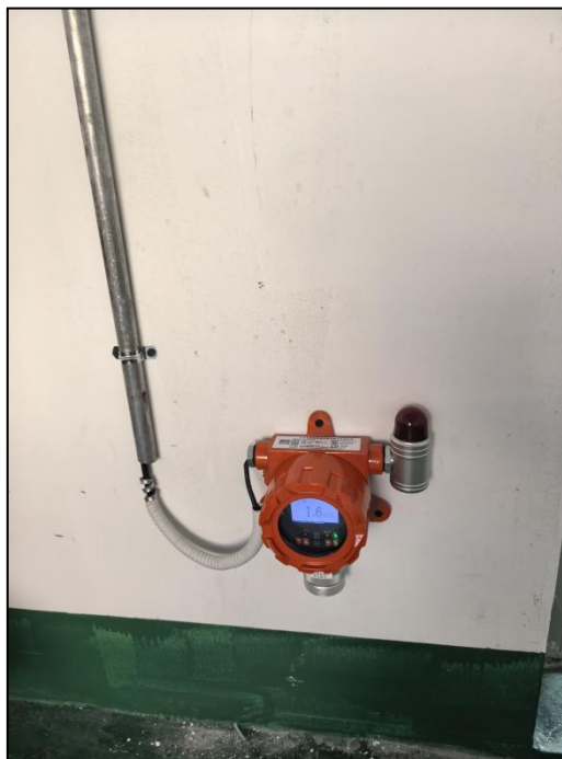
图 4.2-2 化学品中转仓可燃气体报警器
