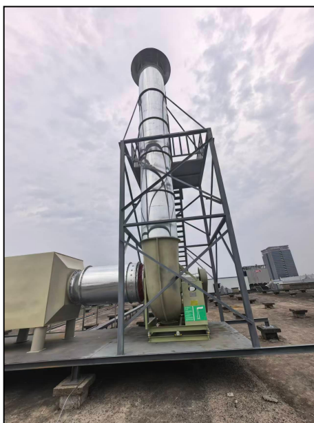
图 4.1-8 干式过滤器+二级及活性炭吸附装置 (TA004) 图 4.1-9 DA004 排气筒
